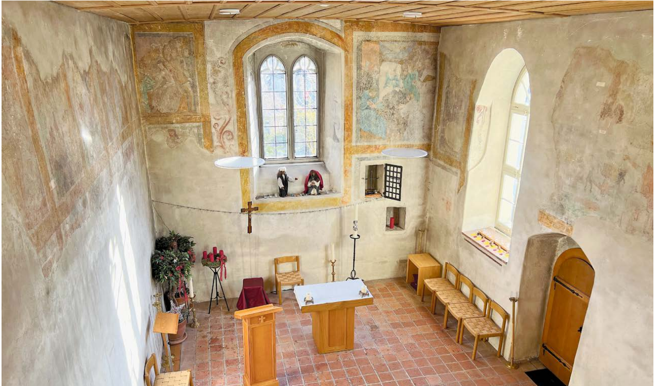
Die Fresken aus dem 15. Jahrhundert sind der eigentliche Schatz der Dorfkapelle – ihre Bewahrung steht nun im Zentrum der Sanierung.
