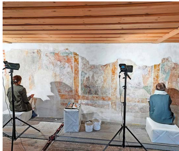
Die Restaurierungsarbeiten an den Wandmalereien sind beinahe abgeschlossen. Bild: zVg/Architekturbüro Johann Frei/Sonja Fasnacht
