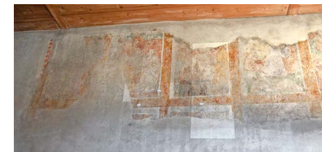
Doris Wargers Werk: In einem Testbereich (Mitte) konnte die Wandmalerei in der Kapelle Uhwiesen wieder hervorgehoben werden.
